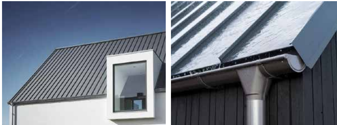
Eksempel på plannja trend 475, PL 15 mørk sølv metallic tak og detaljering rundt nedløpsrør.
