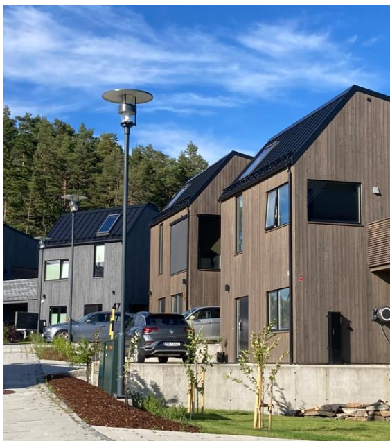
Eksempler fra Drangsvann på hvordan støttemur mellom tomtene kan løses. Th. er nivå forskjellen mere enn 0,5 meter, og i stedet for rekkverk er det brukt plantekasse som sikring.
