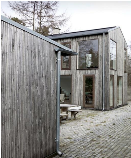
Tv. eksempel på presis og enkel detaljering av nedløpsrør og overgang tak-fasade. Th. eksempel fra Drangsvann på enkel og nett detaljering rundt dør og overgang tak-fasade.
