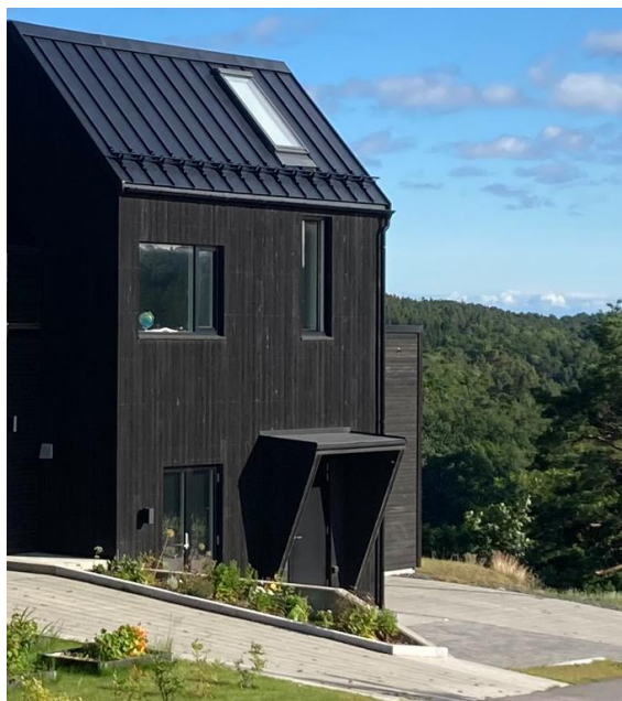
Eksempler fra Drangsvann på hvordan støttemur mellom tomtene kan løses. Th. er nivå forskjellen mere enn 0,5 meter, og i stedet for rekkverk er det brukt plantekasse som sikring.
