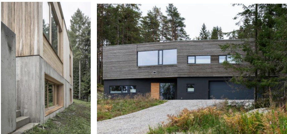
Eksempel Tv. på bruk av lys betong i sokkel etasje. Th. Eksempel på puss i sokkel etasjen th.
