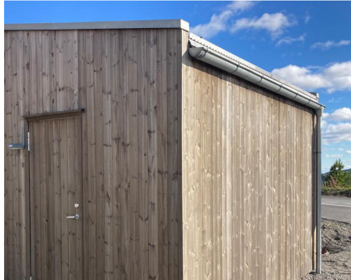
Tv. eksempel på presis og enkel detaljering av nedløpsrør og overgang tak-fasade. Th. eksempel fra Drangsvann på enkel og nett detaljering rundt dør og overgang tak-fasade.
