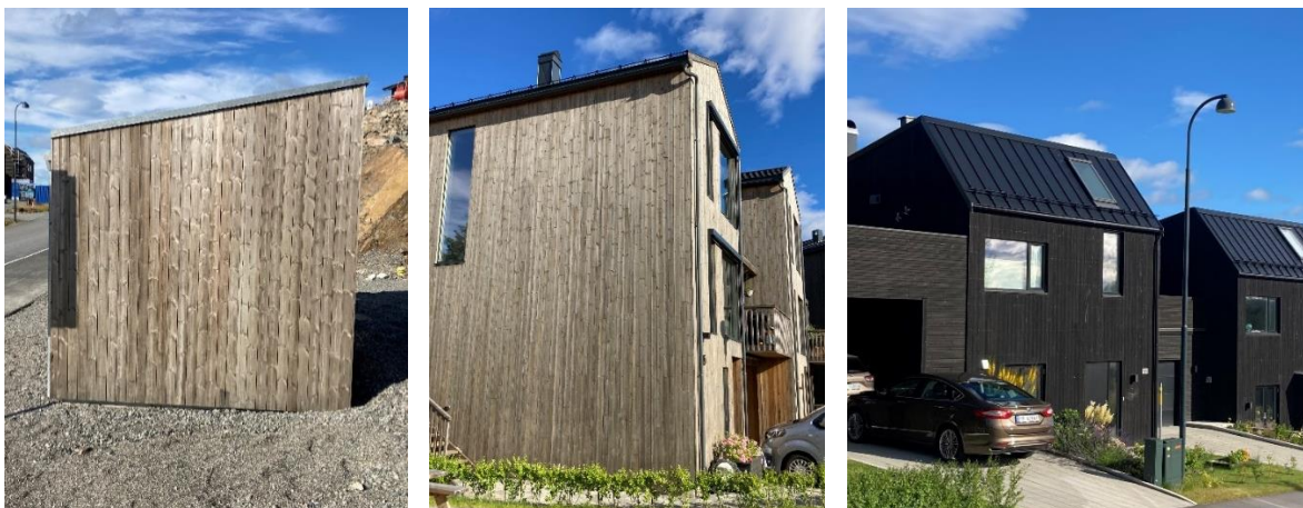
Eksempel fra Drangsvann på ulike typer trekledning. Tv. Varmebehandlet furu. M. Royalimpregnert kledning upigmentert vårgrå. Th. Royalimpregnert kledning nordisk sort RS.30
