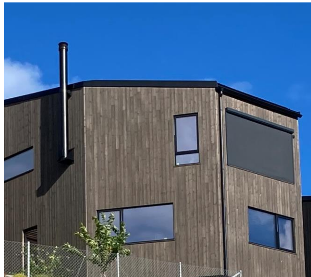
Tv. eksempel fra Drangsvann på ikke ønskelig skjøtebord rundt vinduer på sokkeletasjen. Th. eksempel fra Drangsvann på dominerende gesimsbeslag som ikke er ønskelig. Pipe bør også innlemmes i byggets form og ikke legges utenpå som vist på eksempel.
