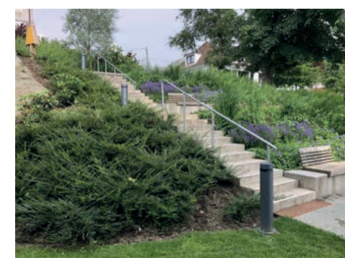
Betongtrapp med sitteplasser
