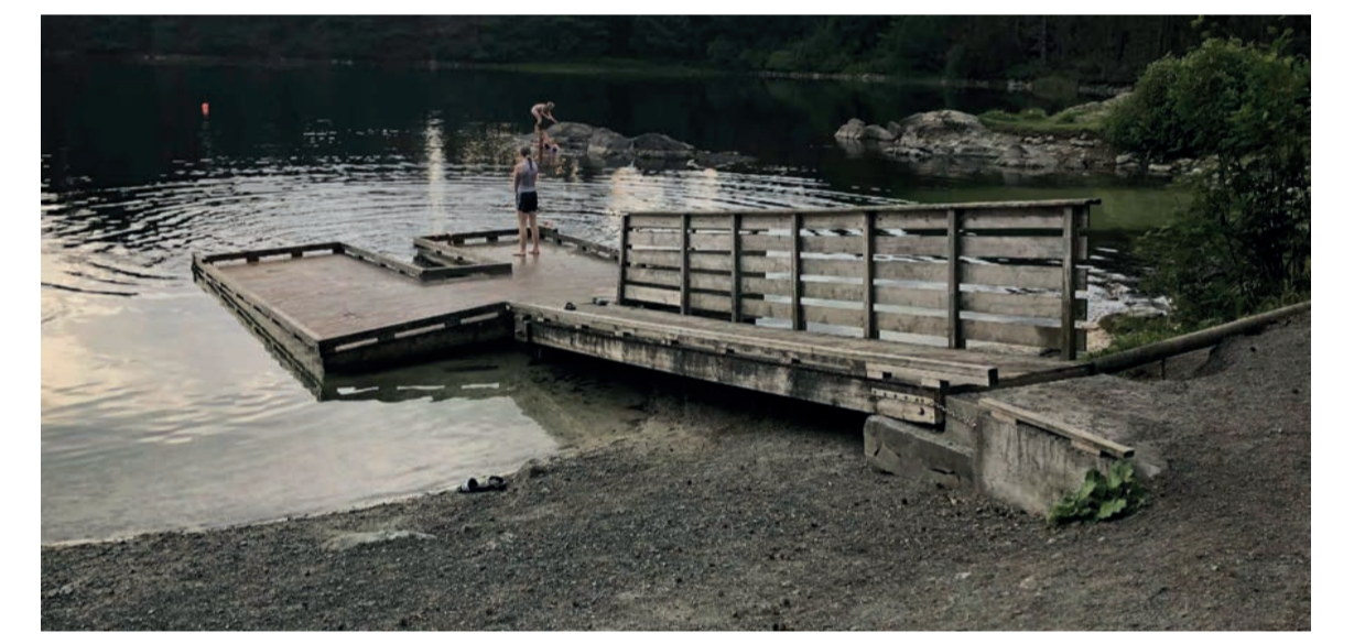
Flytebrygge festes i land med betongklosse
