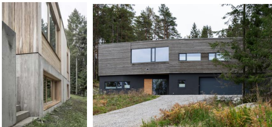
Eksempel Tv. på bruk av lys betong i sokkel etasje. Th. Eksempel på puss i sokkel etasje th.
