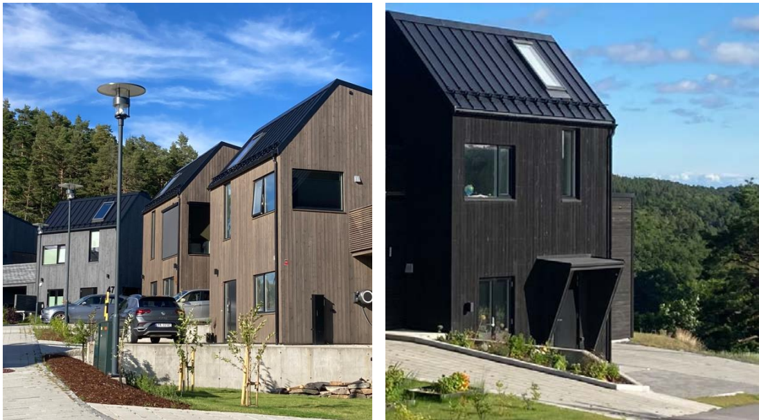
Eksempler fra Drangsvann på hvordan støttemur mellom tomtene kan løses. Th. er nivå forskjellen mere enn 0,5 meter, og i stedet for rekkverk er det brukt plantekasse som sikring.
