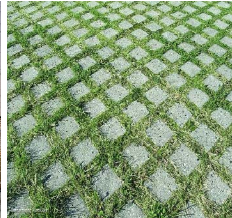
Tv. eksempel på biloppstillingsplass integrert som en naturlig del av boligen, eller som forlengelse av boligens arkitektur. Th. Referanse på gressarmering som kan brukes som drenerende masse i forbindelse med oppkjørsel og utendørsparkeringsplasser.
