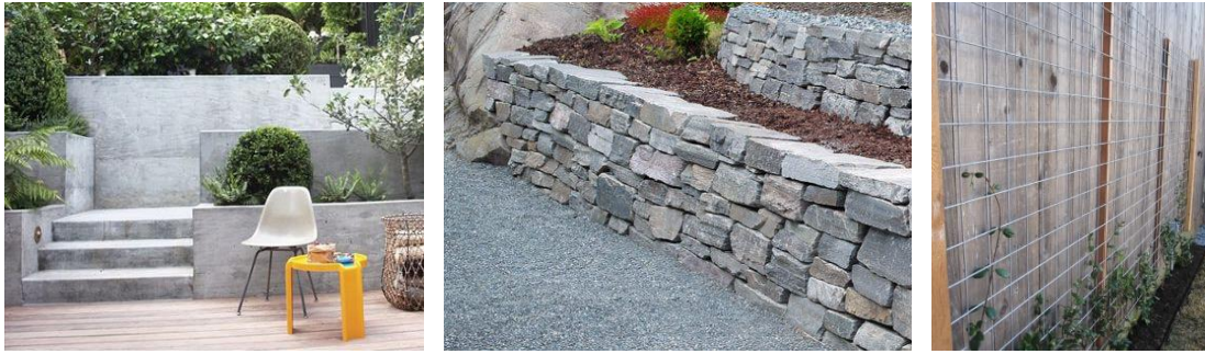
Eksempler på støttemur: Tv. terrassert støttemur i betong. M. stable stein i lokal stein. Th. espalier langs vegg
