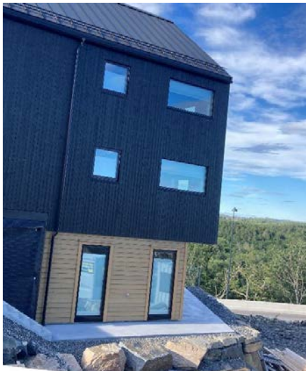
Tv. eksempel fra Drangsvann på ikke ønskelig skjøtebord rundt vinduer på sokkeletasjen. Th. eksempel fra Drangsvann på dominerende gesimsbeslag som ikke er ønskelig. Pipe bør også innlemmes i byggets form og ikke legges utenpå som vist på eksempel.
